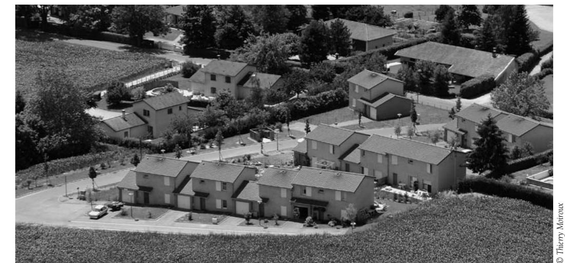
La Presle (Buellas) : construction de 10 logements en maisons individuelles groupées allées des Moissons et de la Batteuse à Buellas (2001).
