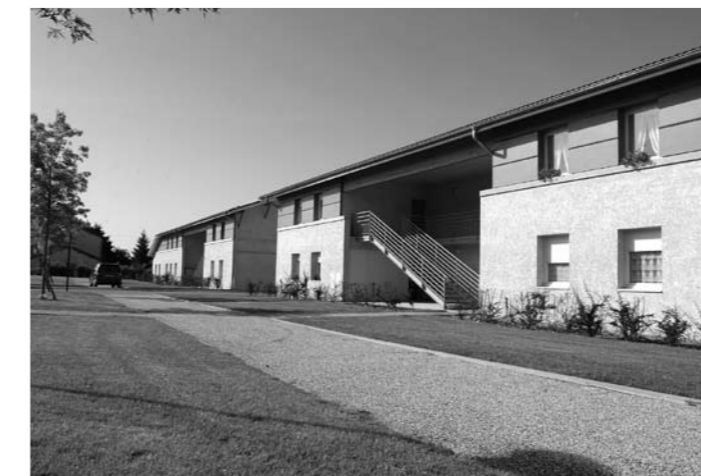
Les Etendières (Viriat) : construction de 42 logements dont 21 maisons individuelles et 3 petits immeubles de 7 logements rue des Mûriers à Viriat (2001).
